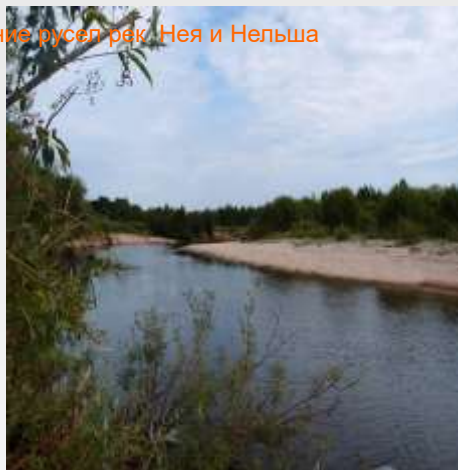
После проведения работ
