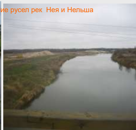
После проведения работ
